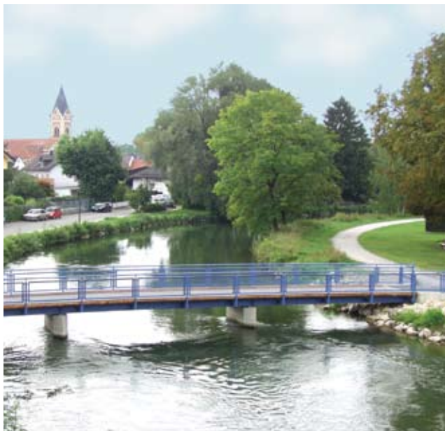
Fußgänger- und Radfahrerbrücke über den Mühlbach: Vom Ortszentrum direkt in die Ampereien
