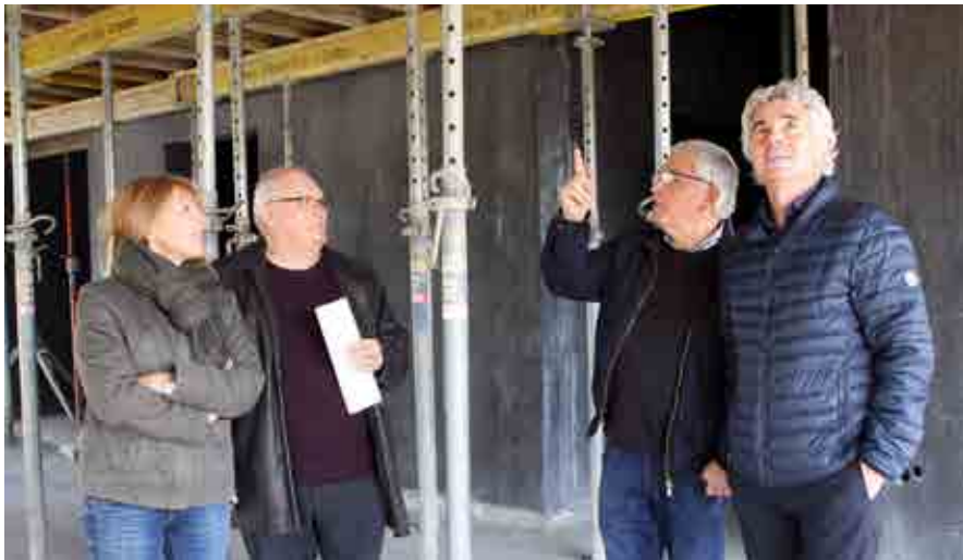
Patricia Conseillon, Michel Peyrard, Georges Reboux et Jean-Pierre Taite sur le chantier du futur cinéma, au Palais.
