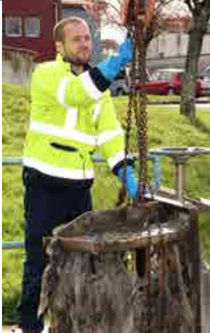
Kévin Verne, qui assure l'entretien de la partie électromécanique, relève manuellement le dégrilleur qui sera automatisé au cours de la première tranche des travaux de réhabilitation. Il effectue également le remplacement d'Arlette Gay durant les congés.
